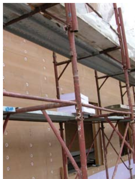
Applicazioni di T-WOOD RASANTE e del ciclo isolante BROWN SYSTEM.
